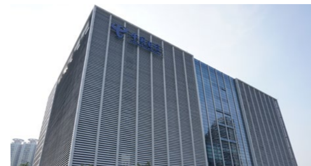
位于广东省广州市海珠区的中国电信广州云计算数据中心是华南以及粤港澳大湾区重要的网络和数据节点之一，2019 年 11 月 19 日，新建的沙溪 IDC 机房交付使用
